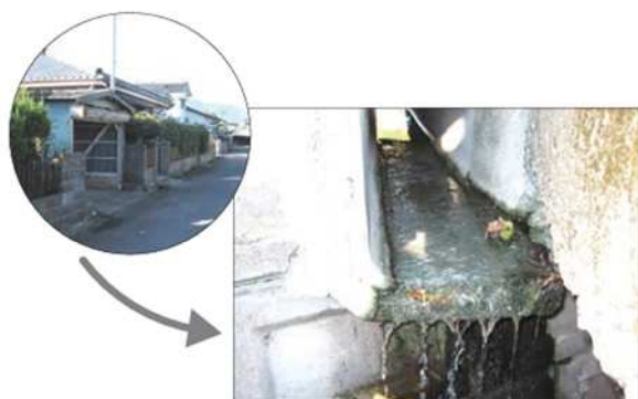
1970年代 単独処理浄化槽設置地域の側溝の例 (白っぽいヘドロ状のものが堆積しています)
