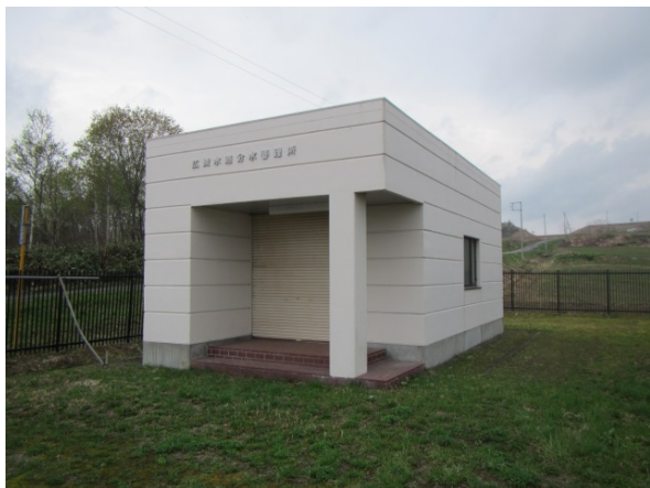
分水管理所（配水池敷地内） (北空知広域水道企業団)
