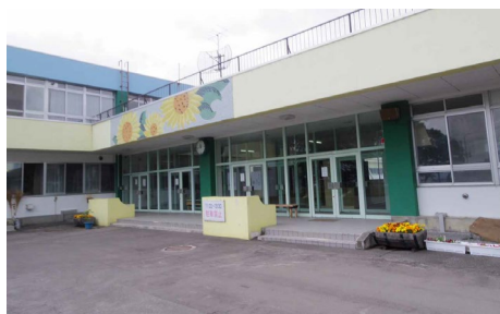
図 北竜中学校 校舎外観
