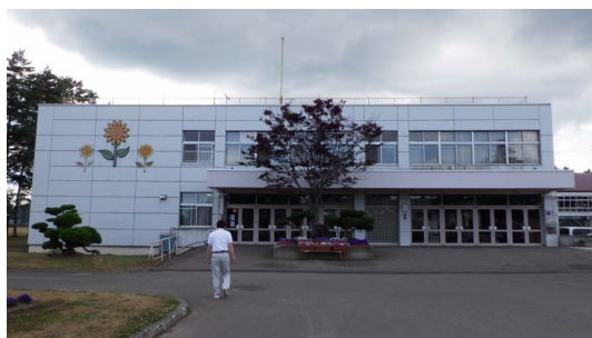
図 真竜小学校 校舎外観
